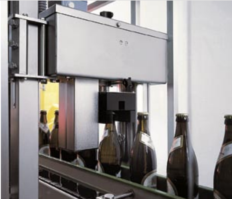
Messbrücke zur Füllhöhenkontrolle mit Röntgensystem und Verschlusskontrolle
